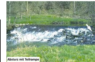
Absturz mit Teilrampe
